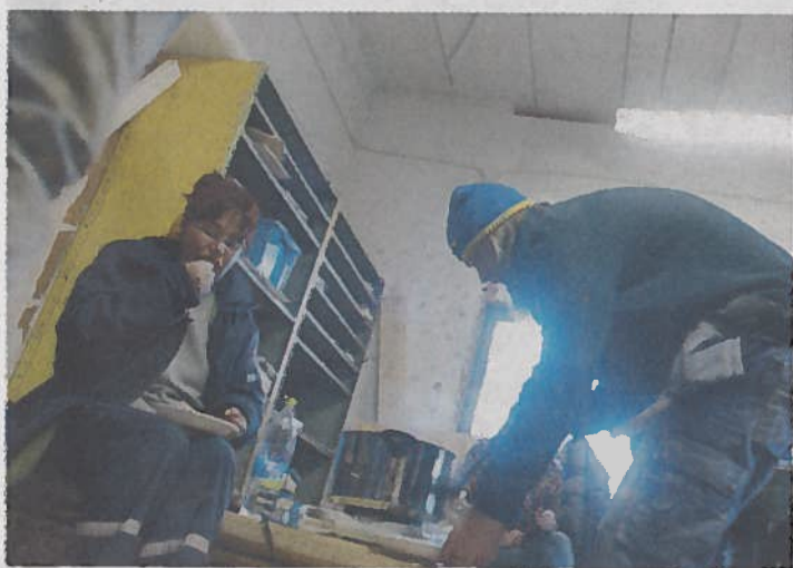
Under renoveringen av nya lokalen byggs det för fullt. Mitt i allt det behövs också matpauser.
